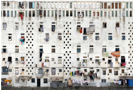
Alger - Cité « Climat de France », Façade n°1 © Stéphane Couturier
